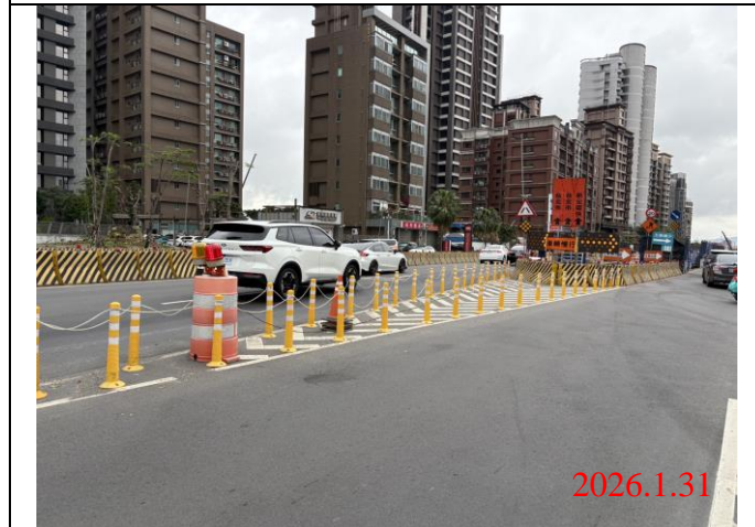
巡查日期地點：115.1.31/ Y23車站 照片說明：牌面設置狀況
