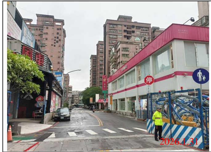
巡查日期地點：115.1.31/ Y21車站 照片說明：牌面設置狀況
