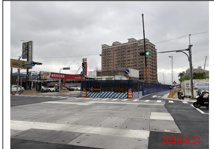
巡查日期地點：115.1.31/ Y22車站 照片說明：牌面設置狀況
