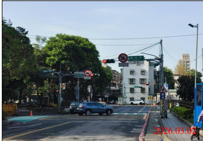
巡查日期地點：115.03.02/ Y23車站 照片說明：牌面設置狀況
