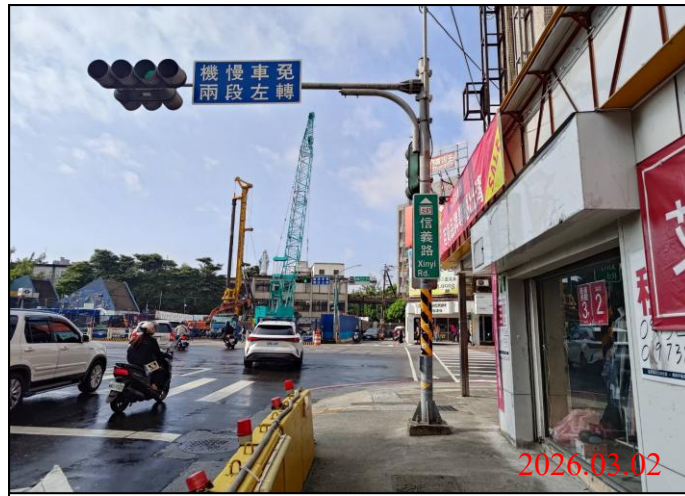
巡查日期地點：115.03.02/ Y21車站 照片說明：牌面設置狀況
