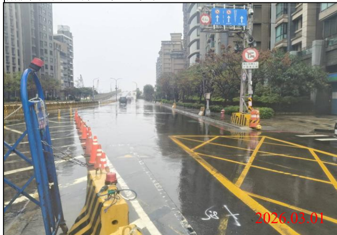
巡查日期地點：115.03.01/ Y23車站 照片說明：牌面設置狀況
