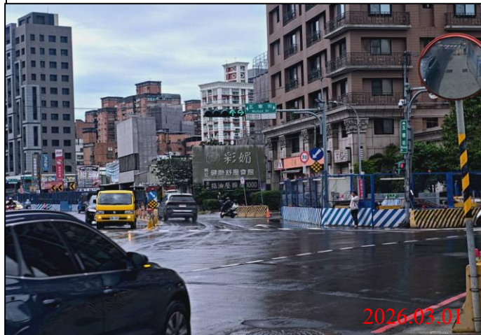
巡查日期地點：115.03.01/ Y22車站 照片說明：牌面設置狀況
