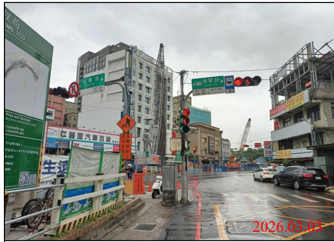
巡查日期地點：115.03.03/ Y21車站 照片說明：牌面設置狀況
