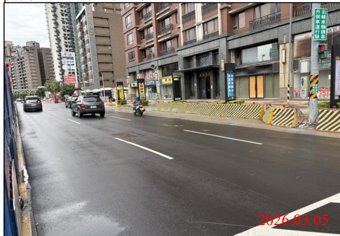
巡查日期地點：115.03.05/ Y23車站 照片說明：牌面設置狀況
