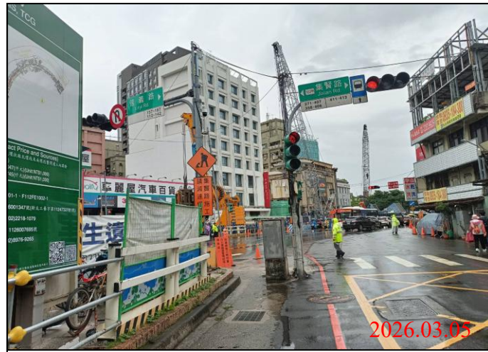
巡查日期地點：115.03.05/ Y21車站 照片說明：牌面設置狀況
