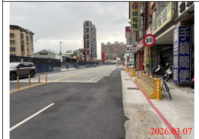
巡查日期地點：115.03.07/ Y22車站 照片說明：牌面設置狀況
