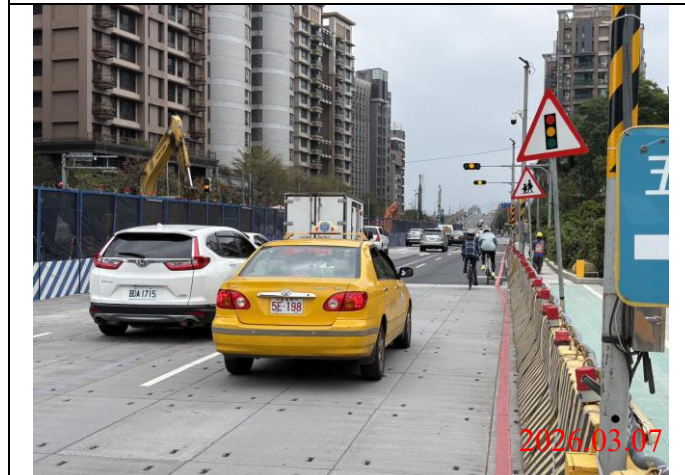
巡查日期地點：115.03.07/ Y23車站 照片說明：牌面設置狀況
