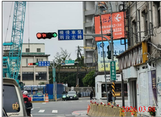
巡查日期地點：115.03.08/ Y21車站 照片說明：牌面設置狀況
