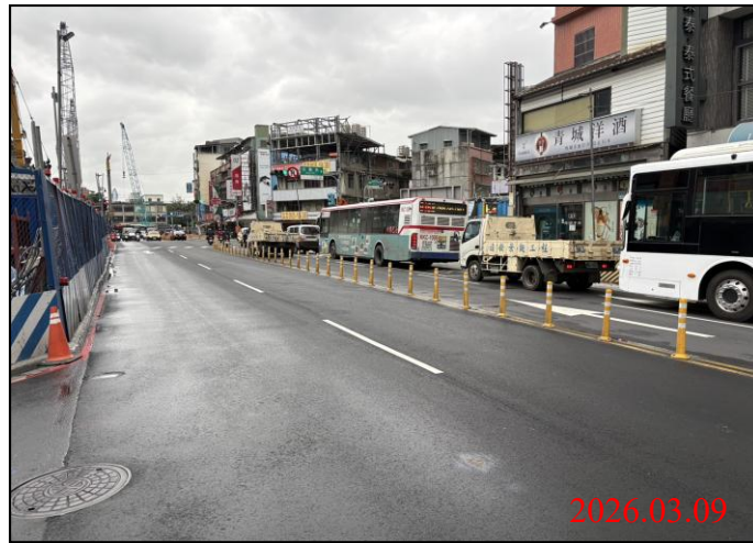
巡查日期地點：115.03.09/ Y21車站 照片說明：牌面設置狀況
