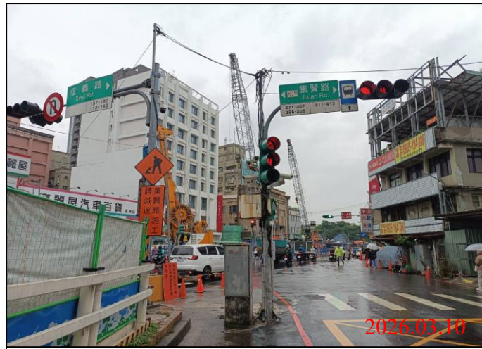
巡查日期地點：115.03.10/ Y21車站 照片說明：牌面設置狀況
