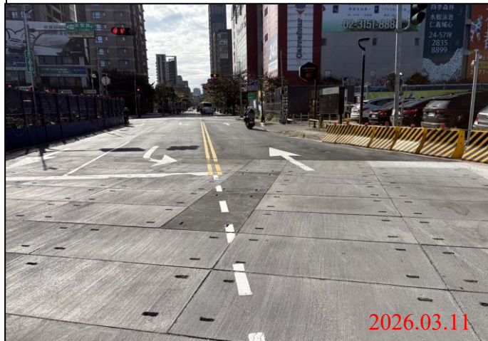
巡查日期地點：115.03.11/ Y22車站 照片說明：牌面設置狀況
