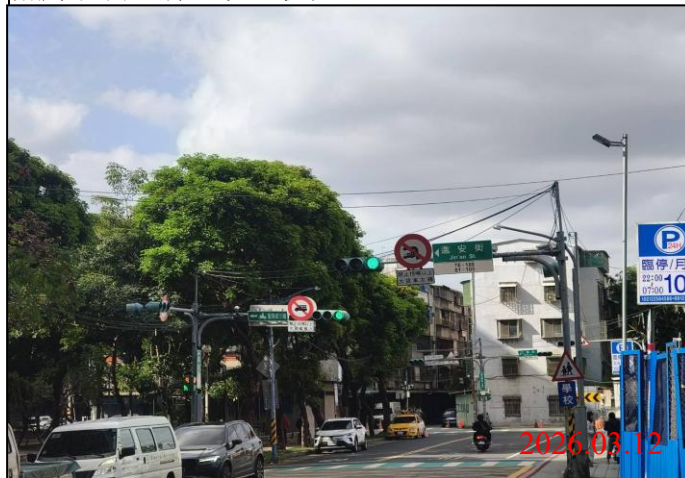
巡查日期地點：115.03.12/ Y23車站 照片說明：牌面設置狀況
