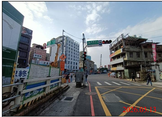
巡查日期地點：115.03.13/ Y21車站 照片說明：牌面設置狀況
