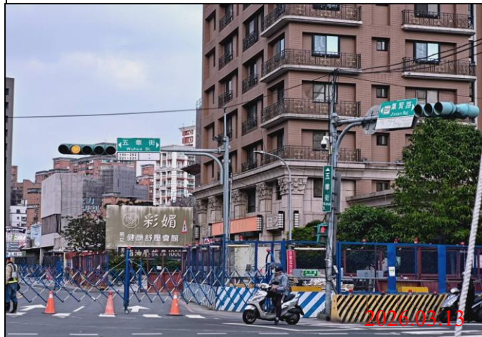
巡查日期地點：115.03.13/ Y22車站 照片說明：牌面設置狀況
