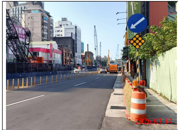
巡查日期地點：115.03.14/ Y21車站 照片說明：牌面設置狀況
