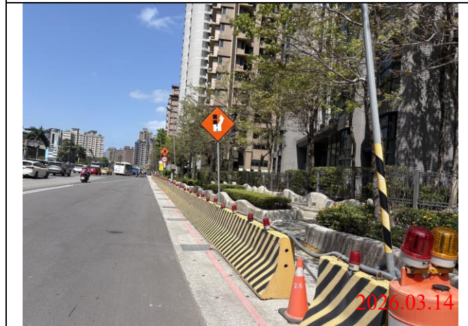
巡查日期地點：115.03.14/ Y23車站 照片說明：牌面設置狀況
