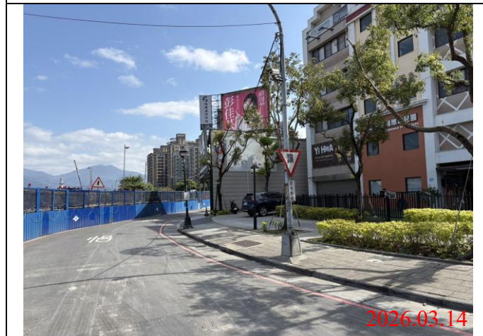
巡查日期地點：115.03.14/ Y22車站 照片說明：牌面設置狀況
