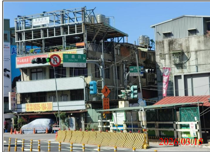
巡查日期地點：115.03.15/ Y21車站 照片說明：牌面設置狀況
