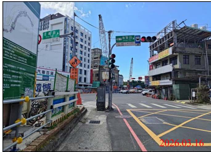
巡查日期地點：115.03.16/ Y21車站 照片說明：牌面設置狀況
