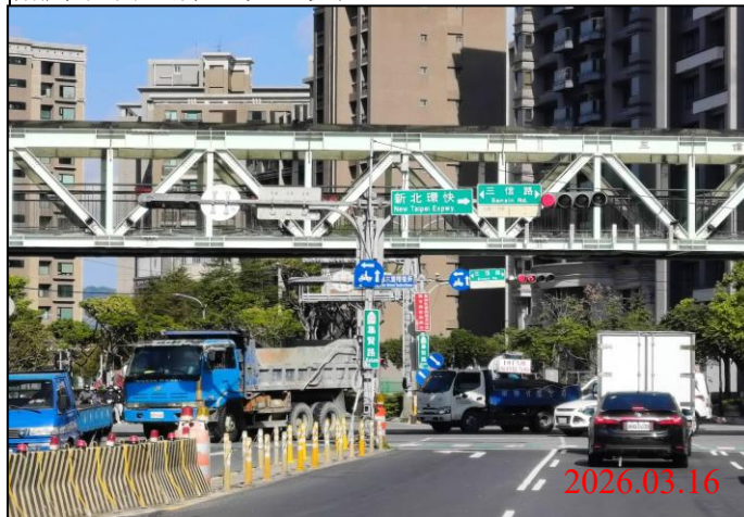
巡查日期地點：115.03.16/ Y23車站 照片說明：牌面設置狀況
