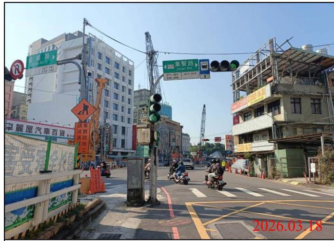
巡查日期地點：115.03.18/ Y21車站 照片說明：牌面設置狀況
