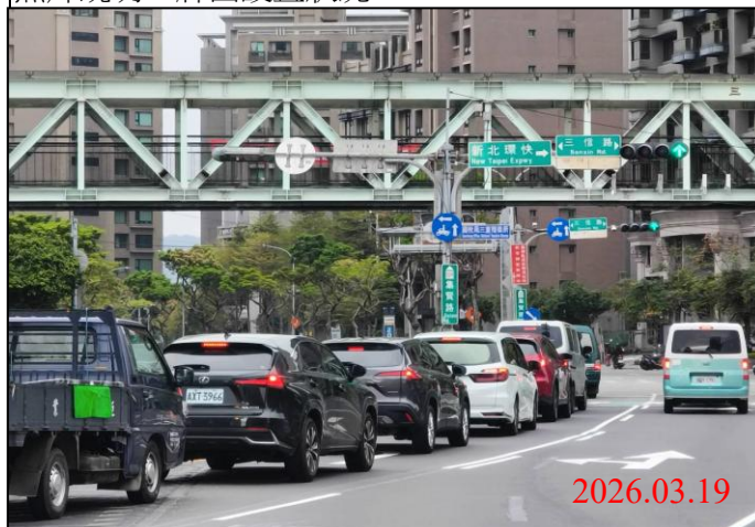
巡查日期地點：115.03.19/ Y23車站 照片說明：牌面設置狀況
