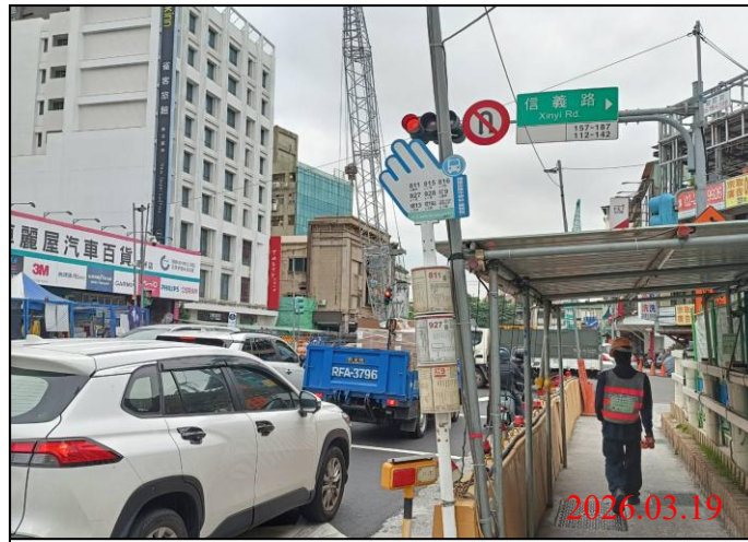
巡查日期地點：115.03.19/ Y21車站 照片說明：牌面設置狀況
