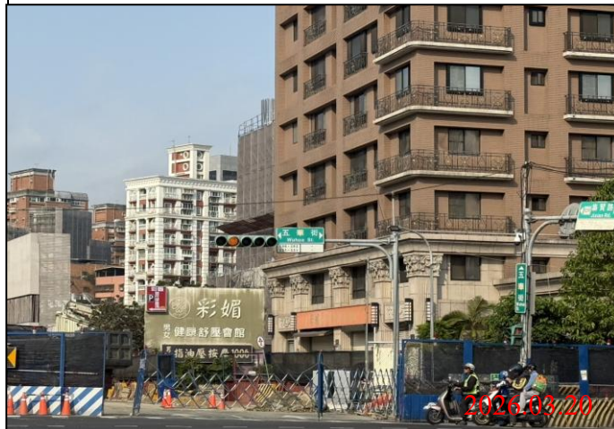
巡查日期地點：115.03.20/ Y22車站 照片說明：牌面設置狀況
