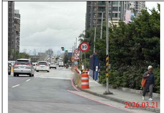
巡查日期地點：115.03.21/ Y23車站 照片說明：牌面設置狀況
