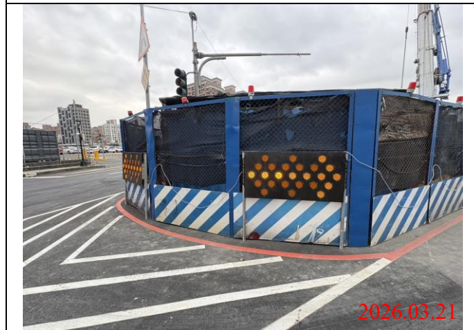
巡查日期地點：115.03.21/ Y22車站 照片說明：牌面設置狀況
