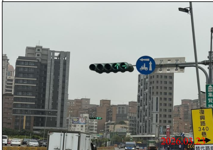
巡查日期地點：115.03.23/ Y22車站 照片說明：牌面設置狀況
