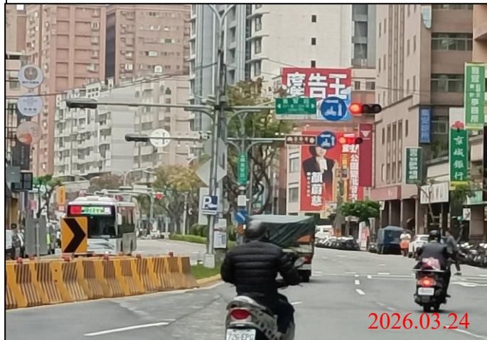
巡查日期地點：115.03.24/ Y22車站 照片說明：牌面設置狀況
