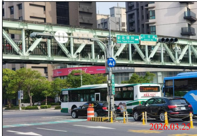
巡查日期地點：115.03.25/ Y23車站 照片說明：牌面設置狀況
