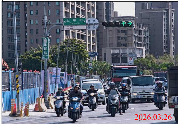
巡查日期地點：115.03.26/ Y22車站 照片說明：牌面設置狀況
