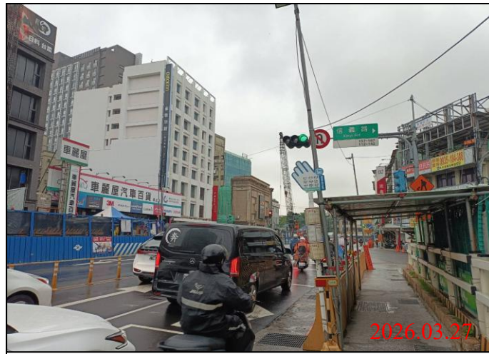
巡查日期地點：115.03.27/ Y21車站 照片說明：牌面設置狀況
