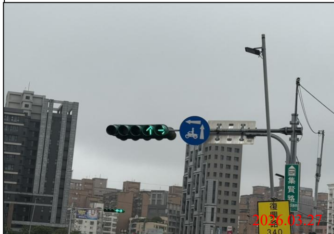
巡查日期地點：115.03.27/ Y22車站 照片說明：牌面設置狀況
