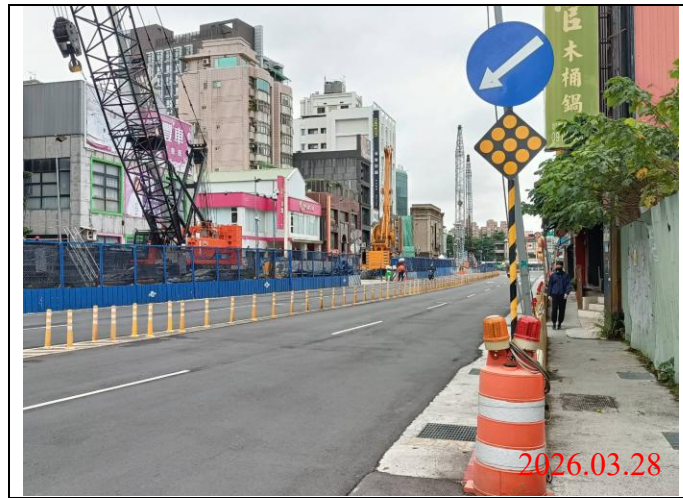
巡查日期地點：115.03.28/ Y21車站 照片說明：牌面設置狀況
