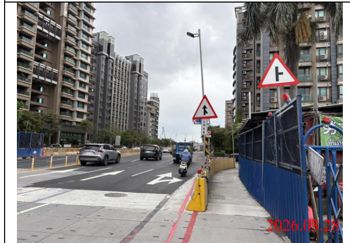
巡查日期地點：115.03.28/ Y23車站 照片說明：牌面設置狀況
