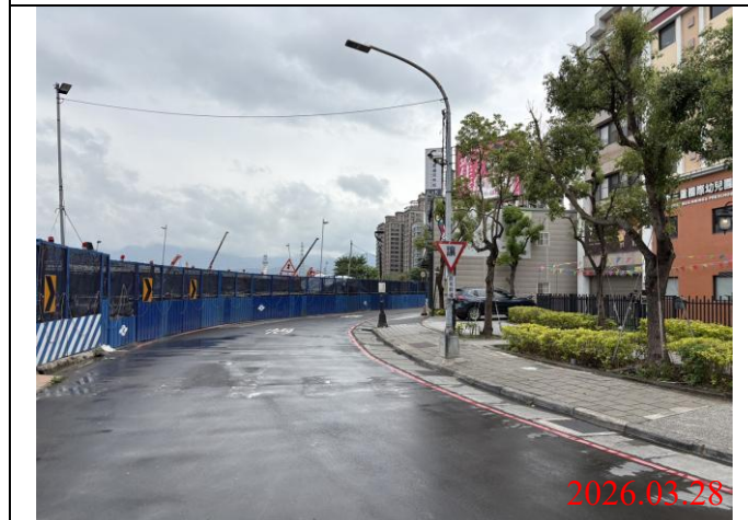
巡查日期地點：115.03.28/ Y22車站 照片說明：牌面設置狀況
