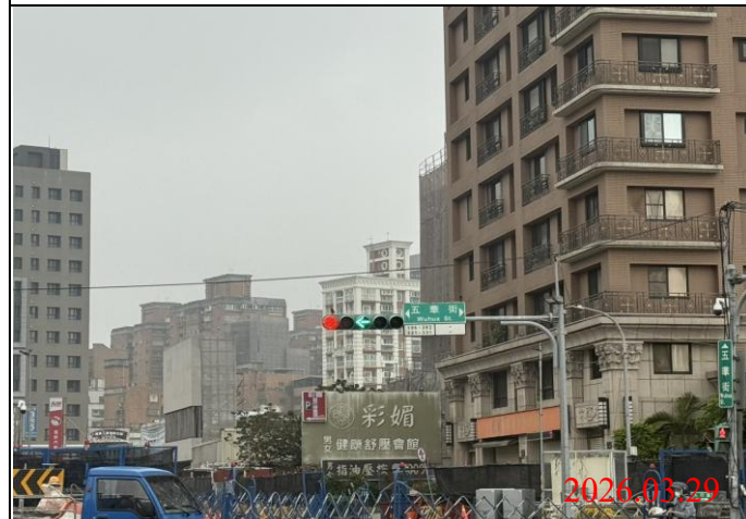
巡查日期地點：115.03.29/ Y22車站 照片說明：牌面設置狀況
