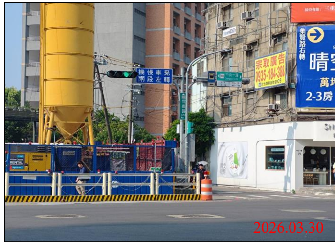
巡查日期地點：115.03.30/ Y21車站 照片說明：牌面設置狀況
