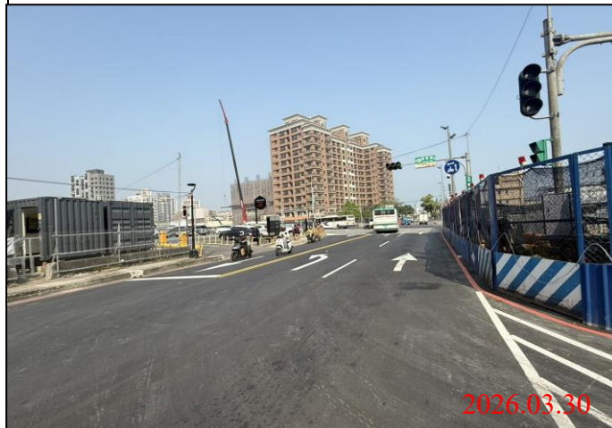
巡查日期地點：115.03.30/ Y22車站 照片說明：牌面設置狀況
