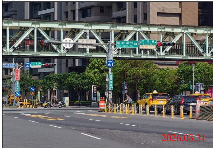
巡查日期地點：115.03.31/ Y23車站 照片說明：牌面設置狀況
