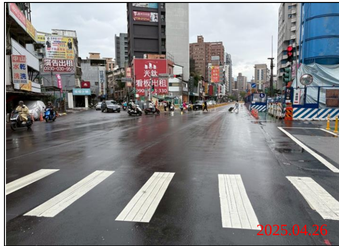
巡查日期地點：114.04.26 / Y21車站 照片說明：牌面設置狀況
