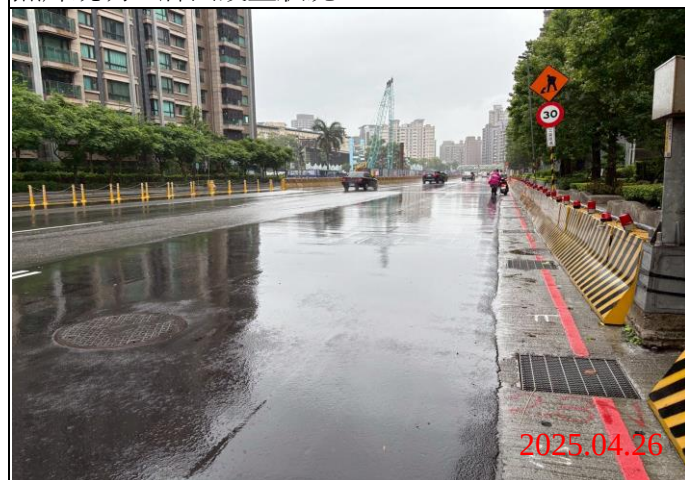
巡查日期地點：114.04.25 / Y23車站 照片說明：牌面設置狀況
