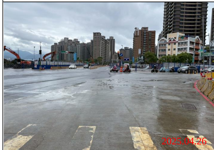
巡查日期地點：114.04.26 / Y22車站 照片說明：牌面設置狀況
