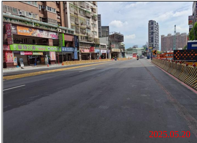
巡查日期地點：114.05.20/ Y22車站 照片說明：路面狀況
