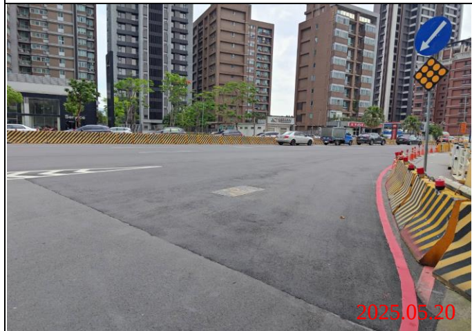
巡查日期地點：114.05.20/ Y23車站 照片說明：路面狀況
