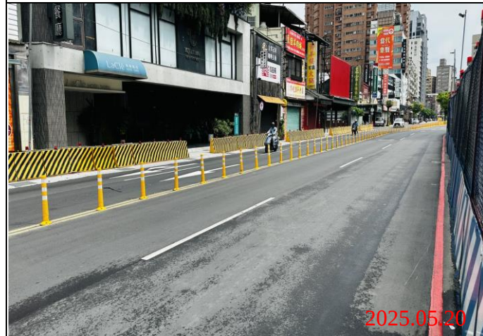
巡查日期地點：114.05.20/ Y21車站 照片說明：路面狀況
