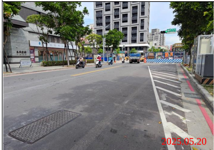
巡查日期地點：114.05.20/ Y22車站 照片說明：路面狀況
