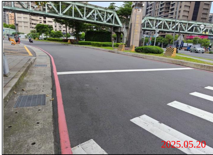
巡查日期地點：114.05.20/ Y23車站 照片說明：路面狀況
