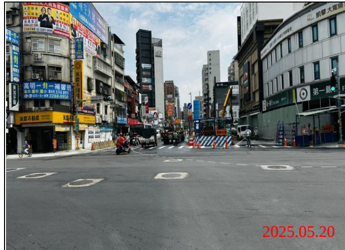
巡查日期地點：114.05.20/ Y21車站 照片說明：路面狀況
