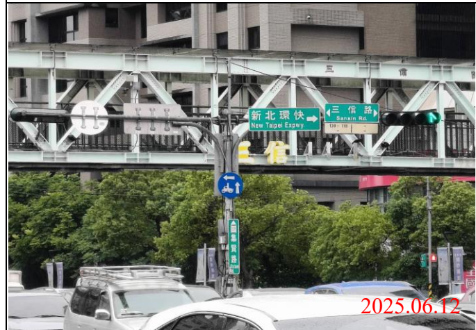
巡查日期地點：114.06.12/ Y23車站 照片說明：牌面設置狀況
