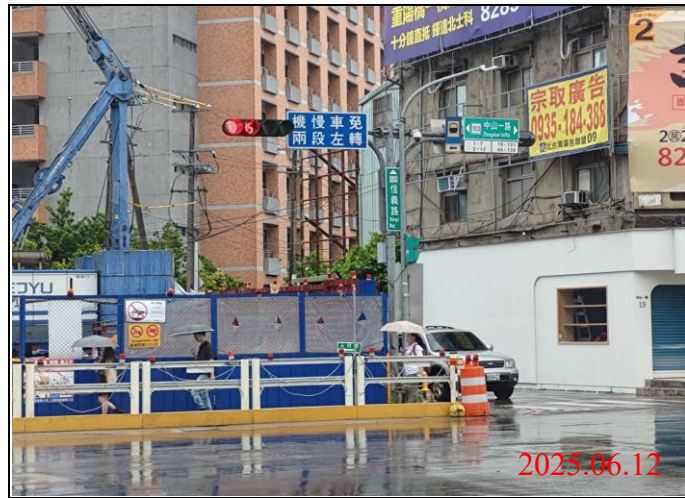
巡查日期地點：114.06.12/ Y21車站 照片說明：牌面設置狀況
