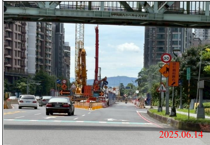
巡查日期地點：114.06.14/ Y23車站 照片說明：牌面設置狀況
