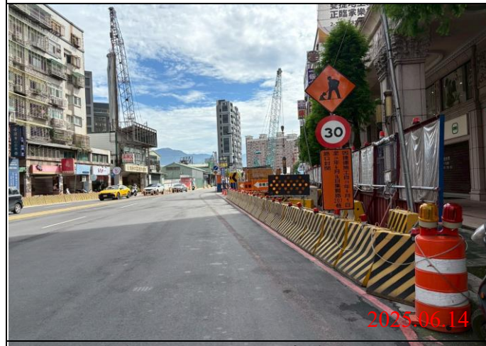
巡查日期地點：114.06.14/ Y22車站 照片說明：牌面設置狀況
