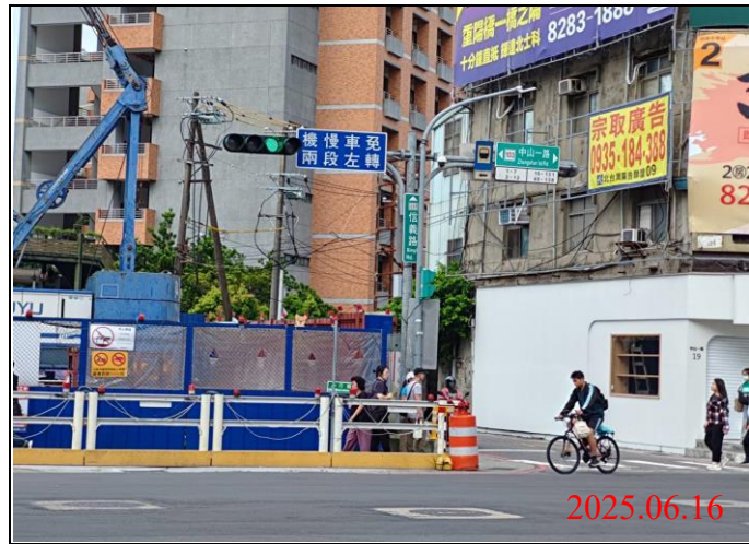
巡查日期地點：114.06.16/ Y21車站 照片說明：牌面設置狀況
