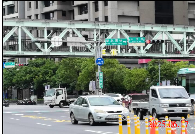
巡查日期地點：114.06.17/ Y23車站 照片說明：牌面設置狀況
