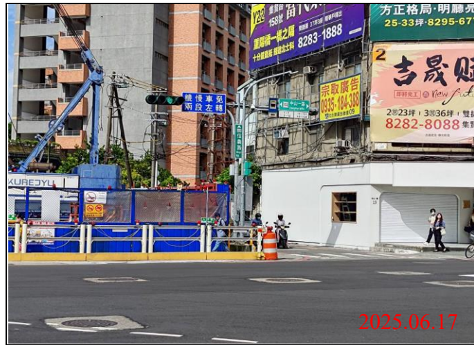
巡查日期地點：114.06.17/ Y21車站 照片說明：牌面設置狀況
