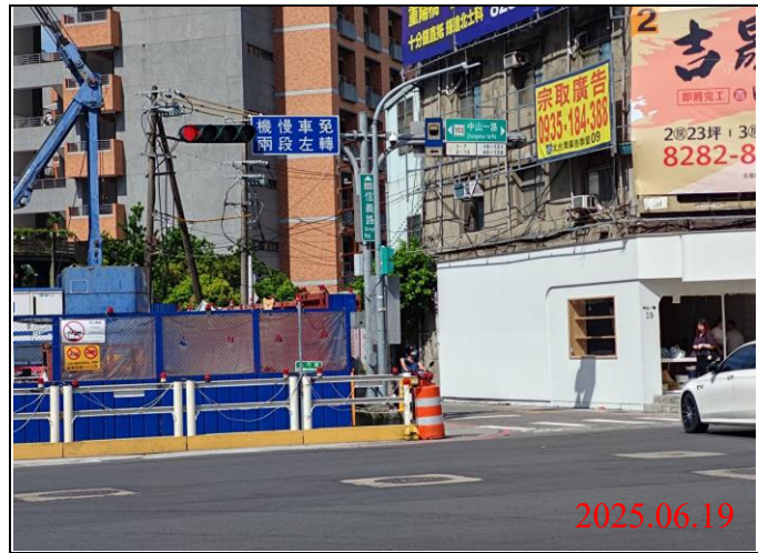
巡查日期地點：114.06.19/ Y21車站 照片說明：牌面設置狀況
