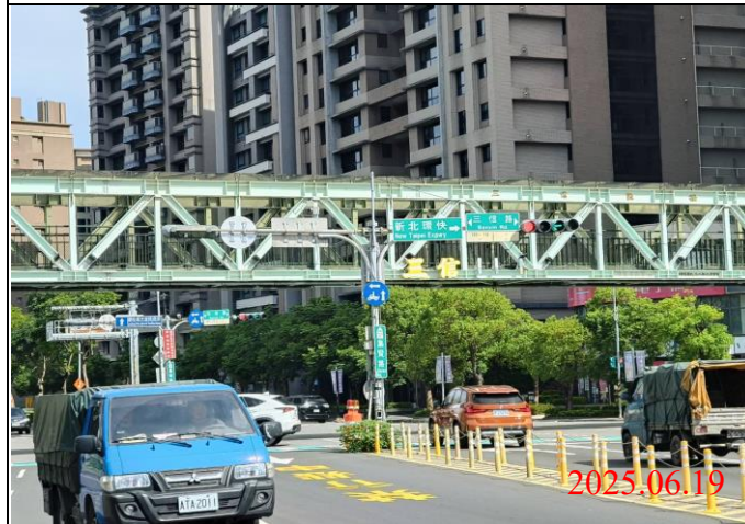
巡查日期地點：114.06.19/ Y23車站 照片說明：牌面設置狀況
