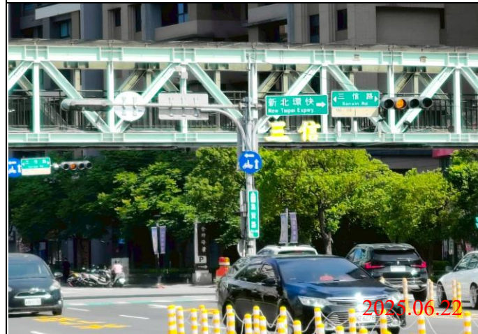
巡查日期地點：114.06.22/ Y23車站 照片說明：牌面設置狀況
