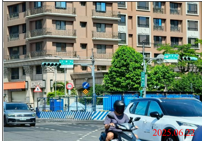
巡查日期地點：114.06.22/ Y22車站 照片說明：牌面設置狀況
