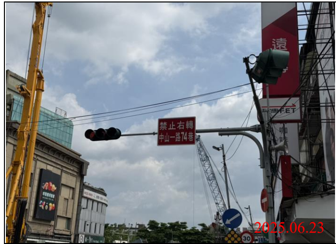
巡查日期地點：114.06.23/ Y21車站 照片說明：牌面設置狀況
