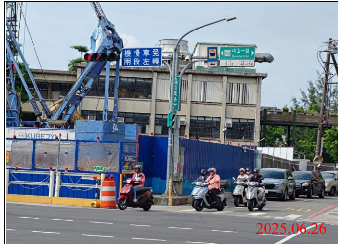
巡查日期地點：114.06.26/ Y21車站 照片說明：牌面設置狀況
