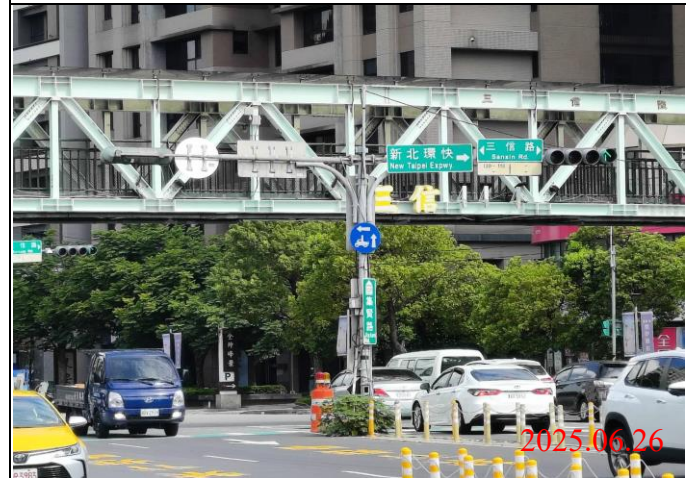
巡查日期地點：114.06.26/ Y23車站 照片說明：牌面設置狀況
