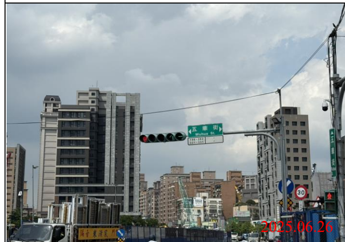
巡查日期地點：114.06.26/ Y22車站 照片說明：牌面設置狀況
