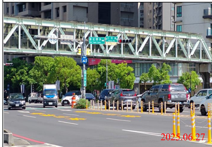
巡查日期地點：114.06.27/ Y23車站 照片說明：牌面設置狀況
