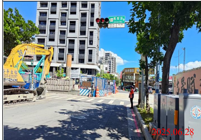
巡查日期地點：114.06.28/ Y22車站 照片說明：牌面設置狀況
