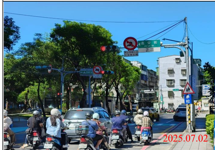
巡查日期地點：114.07.02/ Y23車站 照片說明：牌面設置狀況
