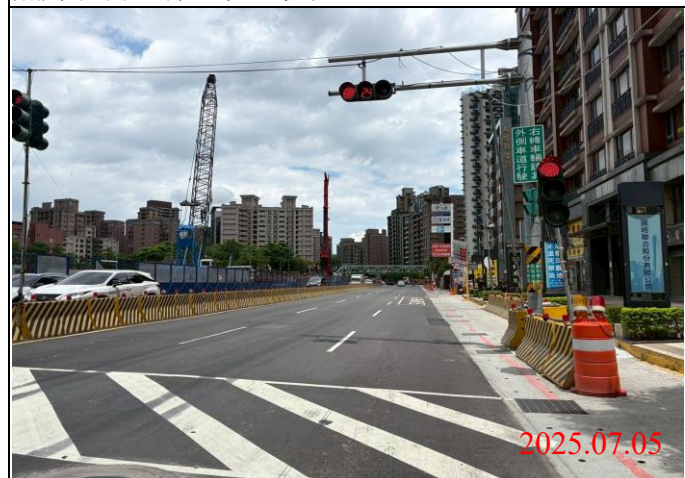
巡查日期地點：114.07.05/ Y23車站 照片說明：牌面設置狀況
