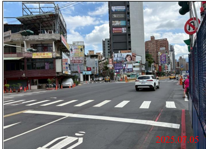
巡查日期地點：114.07.05/ Y21車站 照片說明：牌面設置狀況
