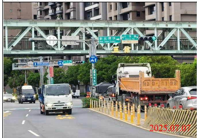
巡查日期地點：114.07.07/ Y23車站 照片說明：牌面設置狀況
