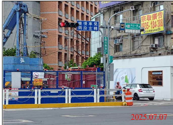
巡查日期地點：114.07.07/ Y21車站 照片說明：牌面設置狀況
