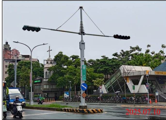
巡查日期地點：114.07.10/ Y21車站 照片說明：牌面設置狀況
