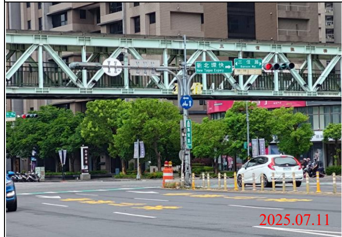
巡查日期地點：114.07.11/ Y23車站 照片說明：牌面設置狀況
