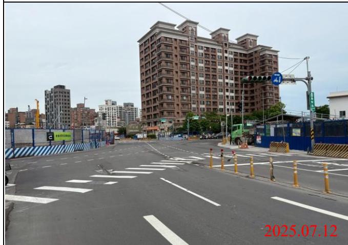
巡查日期地點：114.07.12/ Y22車站 照片說明：牌面設置狀況
