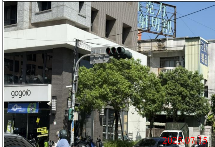
巡查日期地點：114.07.15/ Y22車站 照片說明：牌面設置狀況
