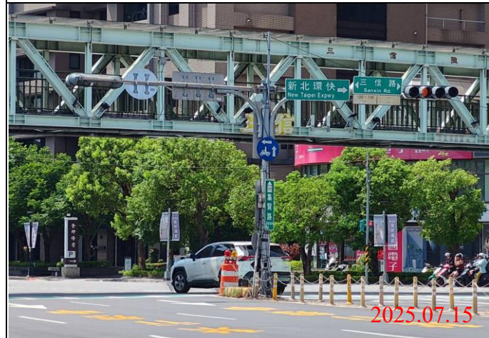
巡查日期地點：114.07.15/ Y23車站 照片說明：牌面設置狀況
