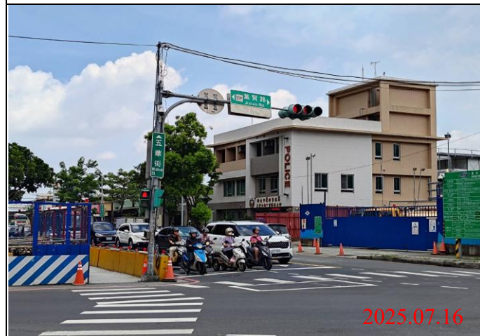
巡查日期地點：114.07.16/ Y22車站 照片說明：牌面設置狀況
