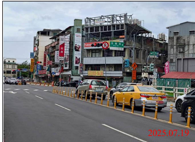
巡查日期地點：114.07.19/ Y21車站 照片說明：牌面設置狀況
