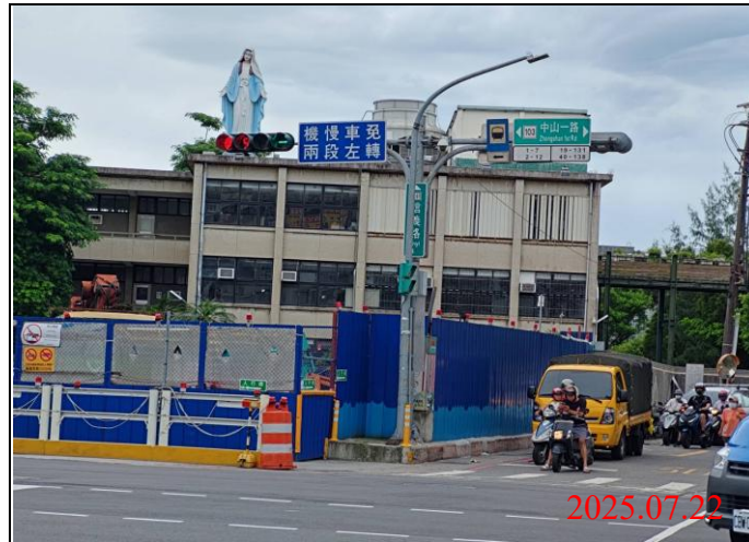
巡查日期地點：114.07.22/ Y21車站 照片說明：牌面設置狀況
