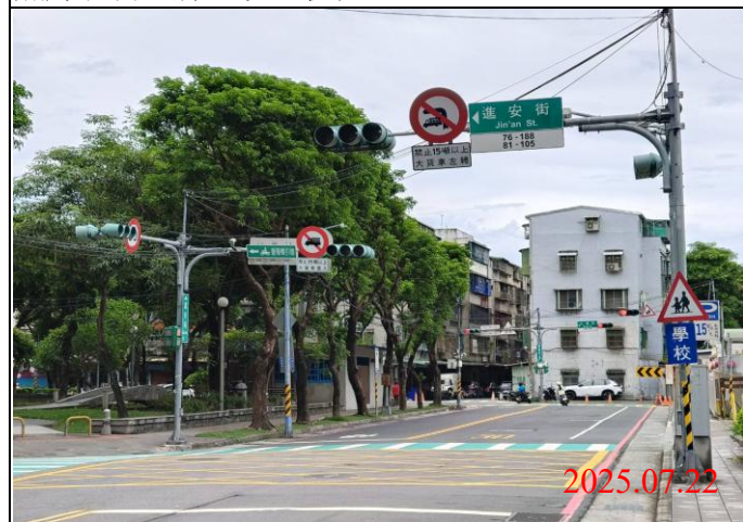
巡查日期地點：114.07.22/ Y23車站 照片說明：牌面設置狀況
