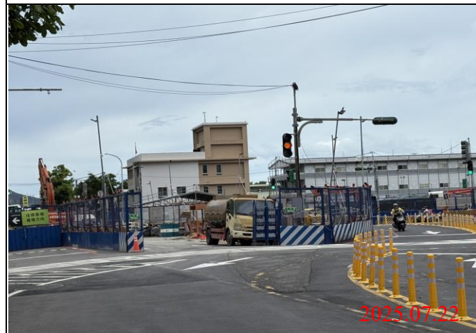
巡查日期地點：114.07.22/ Y22車站 照片說明：牌面設置狀況
